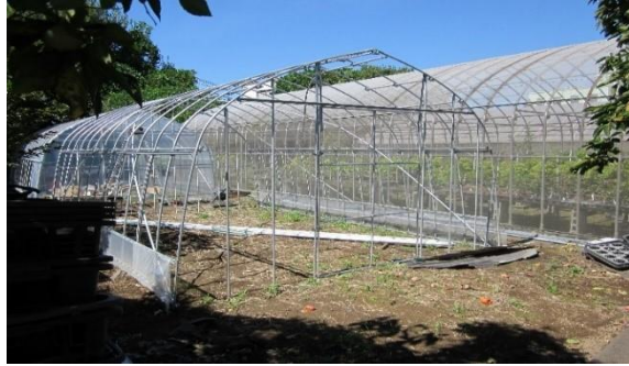
鉄骨が立った状態のハウス2棟
