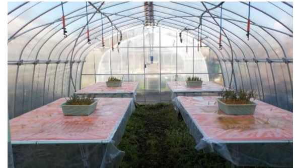
完成後の内部
