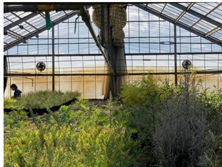
写真1 循環扇の設置状況1
