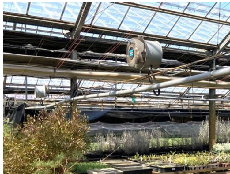
写真2 循環扇の設置状況2
