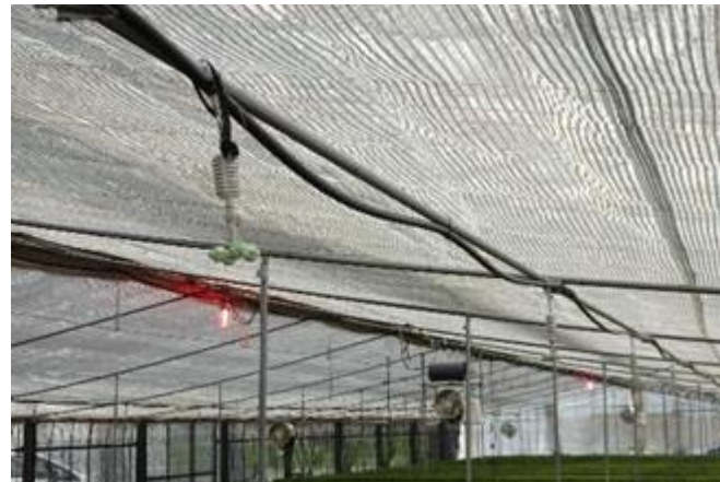
図7 実証区の簡易ミストの噴口ノズル、給水用PEパイプ等
