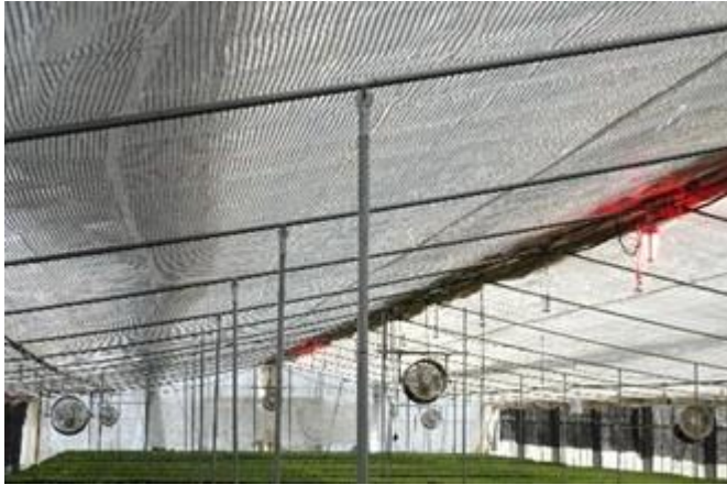
図6 設置後の高機能遮光資材（スリムホワイト）、簡易ミスト、循環扇
