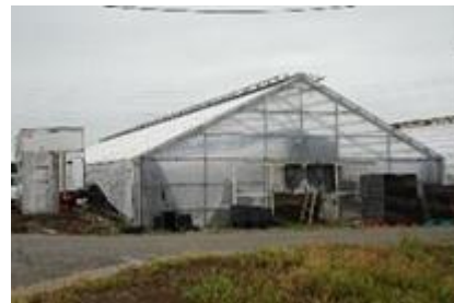
図3 実証区の温室
